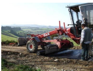
Pose du géotextile
