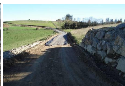
Mise en place du gravier
